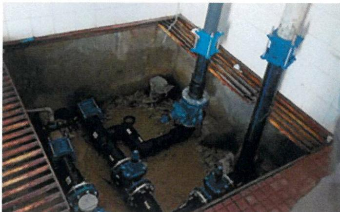
Substituição de conduta de distribuição de água e válvulas de seccionamento em várias ruas na Freguesia de Cadafáz, concelho do Gavião.
