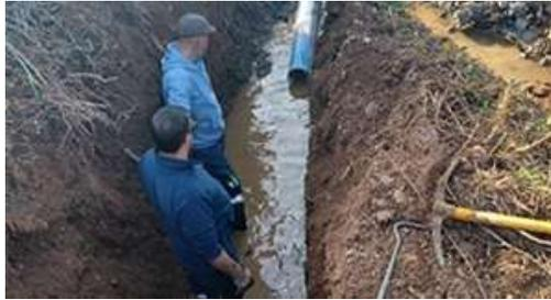
**REPARAÇÃO DE COLETOR DE ESGOTO COM SUBSTITUIÇÃO DE TUBAGEM POR FERRO FUNDIDO, EVITANDO FUTURAS ROTURAS E CONSEQUENTES INFILTRAÇÕES NO MEIO AMBIENTE - SOUSEL**
