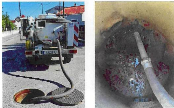
Figura 32 Limpeza da rede de saneamento
